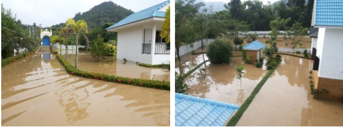
foto : Inondazione nel monastero della santa Dormizione nella provincia di Ratchaburi (9.11.2013)
