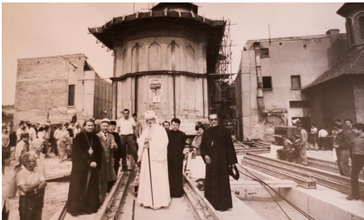
La chiesa Schitul Maicilor in Romania, una delle 13 chiese che sono state spostate su rotaie. Foto: Per gentile concessione di Eugeniu Iordăchescu
